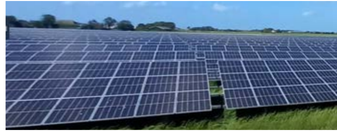
11.00 MWp Art: Freiflächen Anlage Standort: Deutschland Jahr: 2022 Status: Im Aufbau
