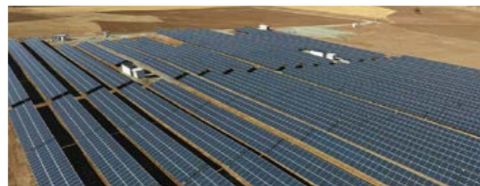
11.00 MWp Tipo: Montato A Terra Anno: 2017 Posizione: Turchia Stato: Completato
