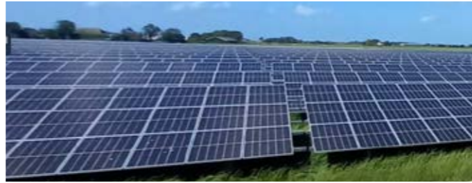
11.00 MWp Tipo: Montato A Terra Anno: 2022 Posizione: Germania Stato: In costruzione
