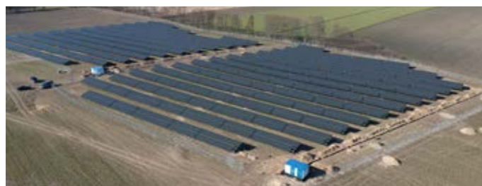
25.00 MWp Tipo: Montato A Terra Anno: 2021 Posizione: Polonia Stato: Completato
