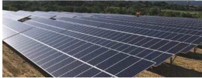
45.60 MWp Tipo: Montato A Terra Anno: 2022 Posizione: Polonia Stato: In costruzione
