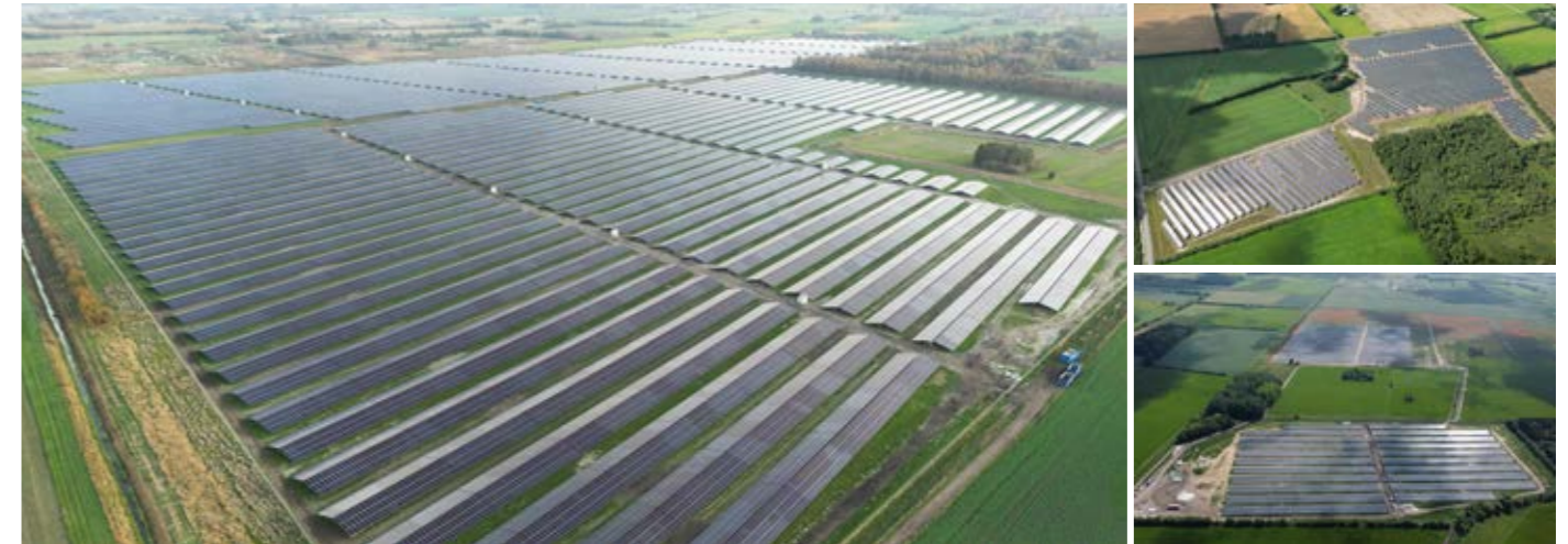
Danimarca Progetti | 328.00 MWp
