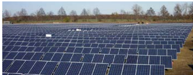
3.40 MWp Tipo: Montato A Terra Anno: 2018 Posizione: Turchia Stato: Completato
