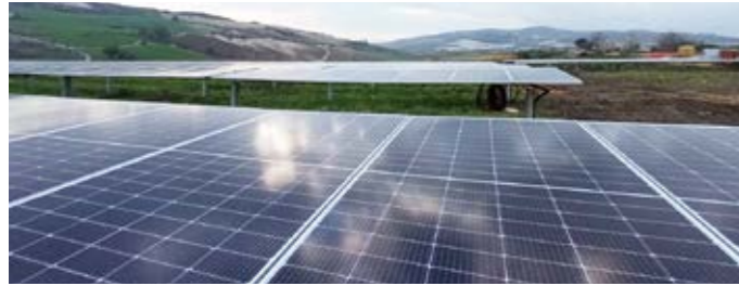
17.00 MWp Tipo: Montato A Terra Anno: 2022 Posizione: Italia Stato: In costruzione
