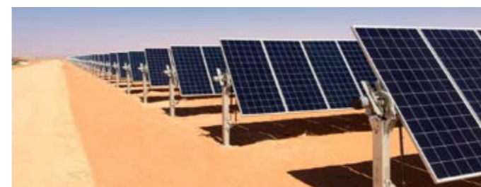
102.00 MWp Tipo: Montato A Terra Anno: 2019 Posizione: Saudi Arabia Stato: Completato
