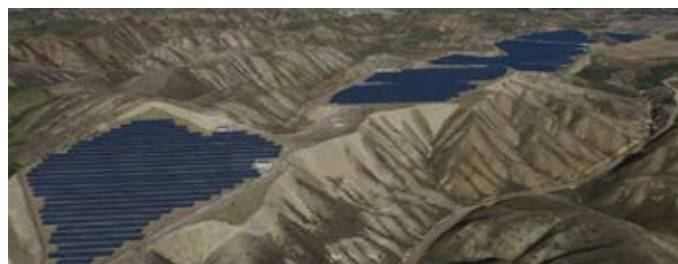
14.00 MWp Tipo: Montato A Terra Anno: 2017 Posizione: Turchia Stato: Completato
